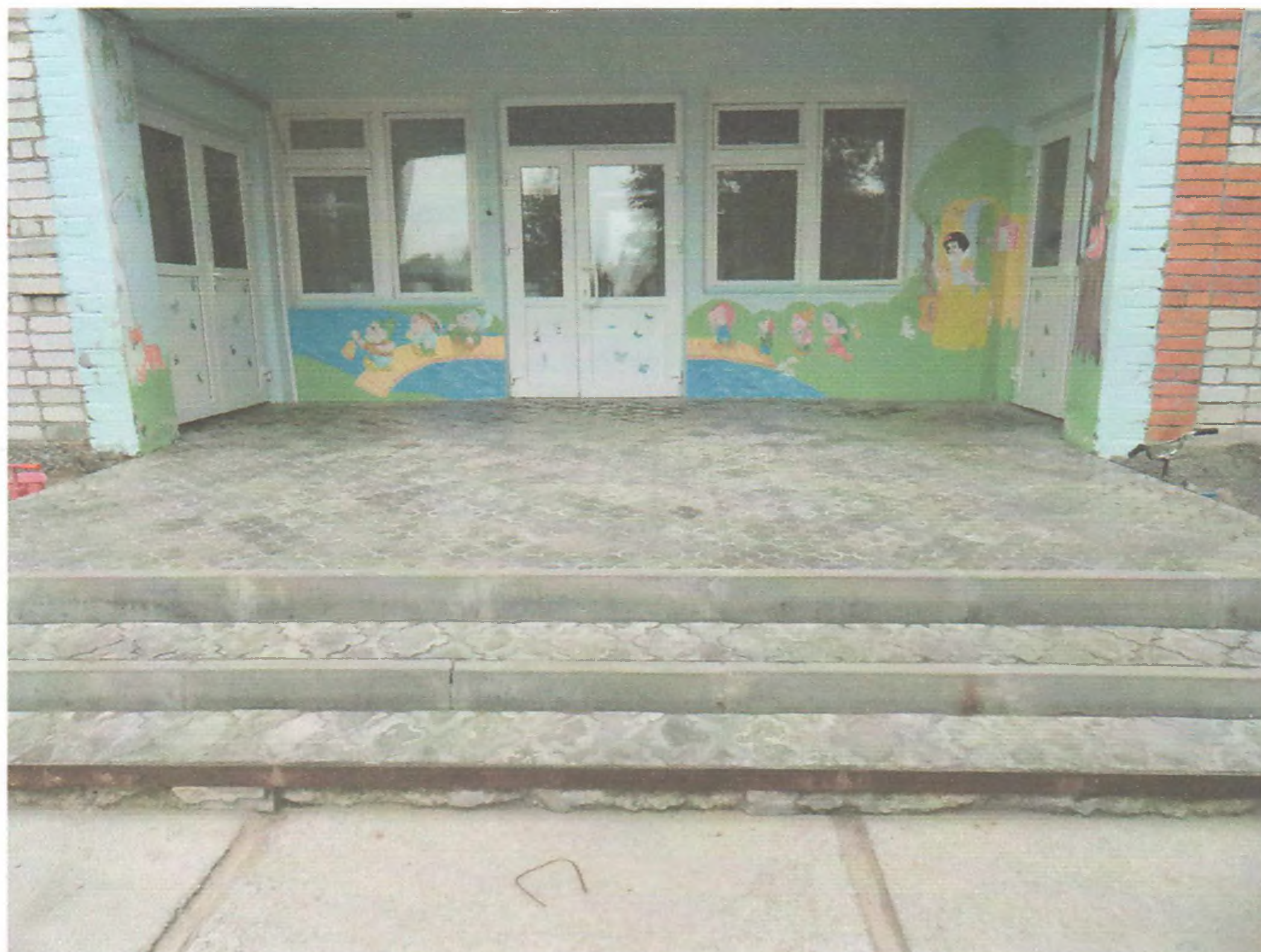
Фото 6. Входная площадка (перед дверью)
