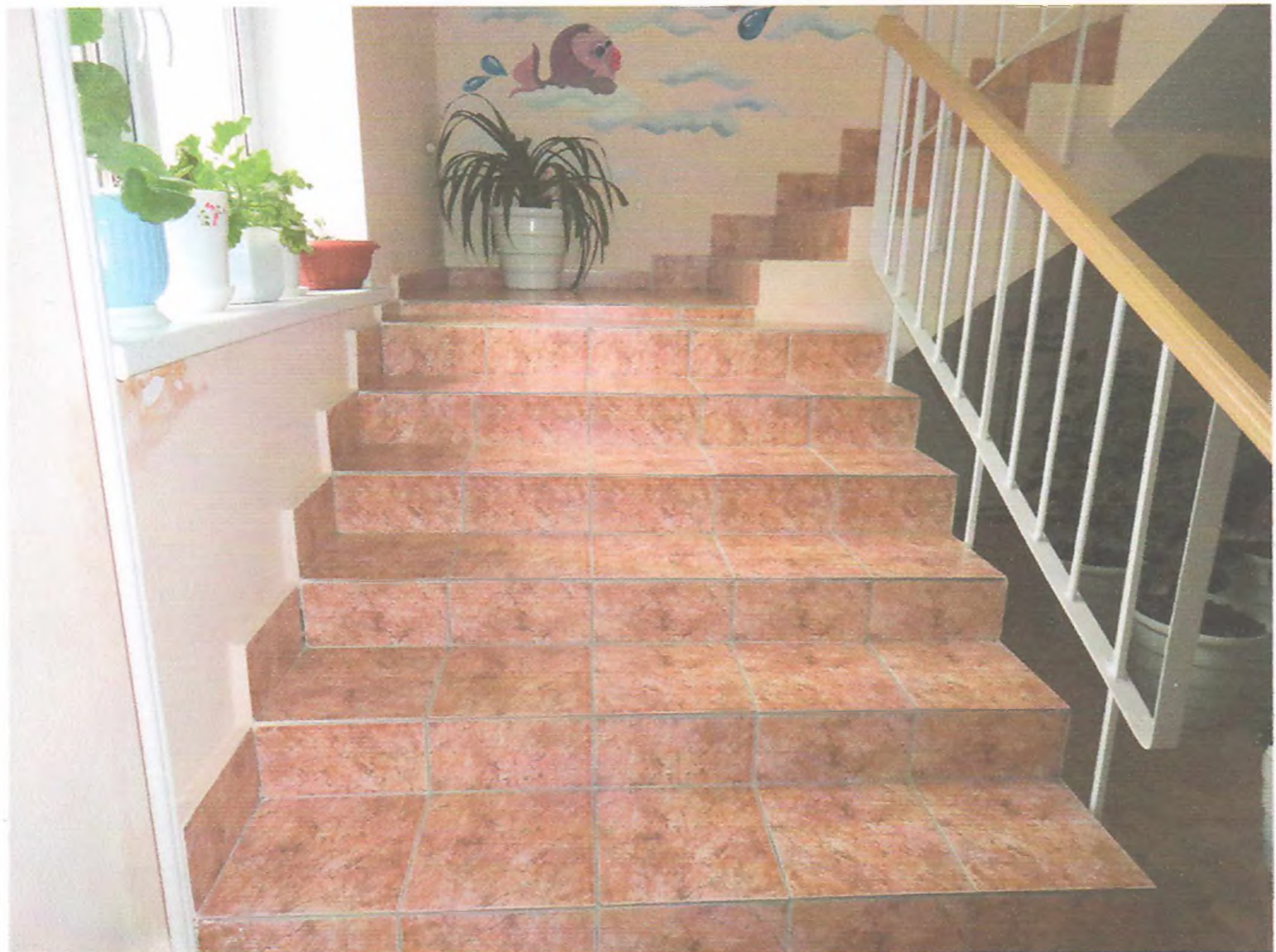
Фото 10. Лестница (внутри здания)
